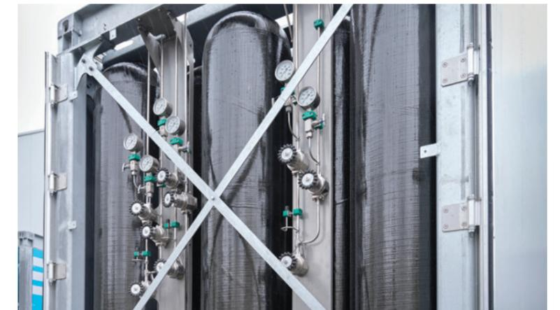
NPROXX hat Produkte für die sichere Speicherung von Wasserstoff unter hohem Druck entwickelt. Unsere Speicherlösungen sind als modulare Anwendungen konzipiert und gestatten die sichere Speicherung großer Wasserstoffmengen, entweder am Produktionsort oder am Ort des Verbrauchs, an Tankstellen und ähnlichen Einrichtungen.
